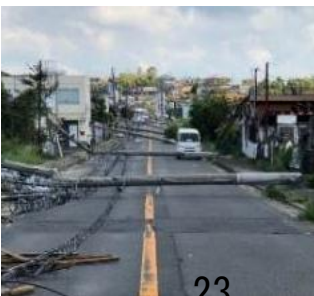
<電柱の倒壊による道路閉塞の事例>
