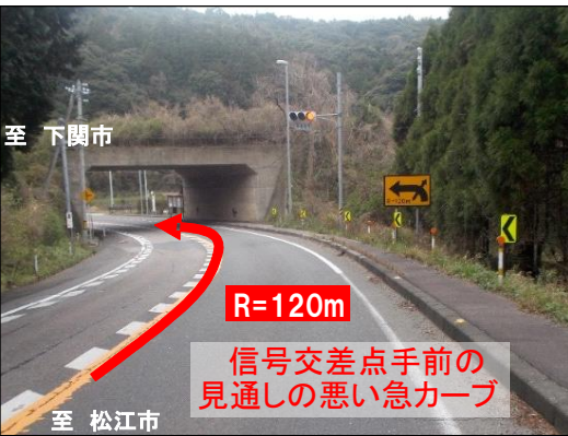
写真① 線形不良箇所・益田市飯浦町付近
