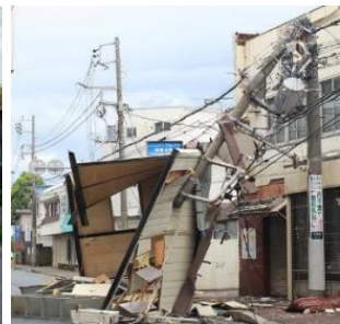
<飛来物による電柱倒壊の事例>
