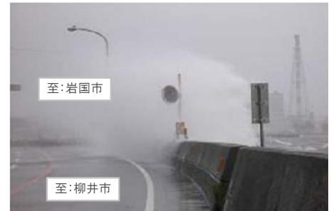
【写真①】越波の状況
