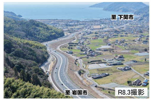
【写真①】4車線開通後(石原地区)
