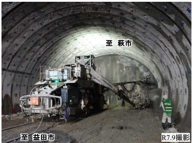
【写真①】木与第1トンネルの施工状況
