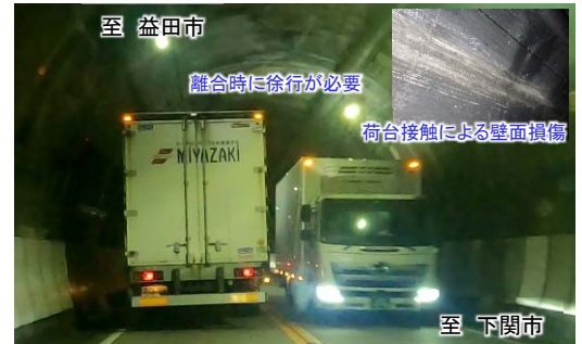
【写真②】トンネルの大型車通行状況
