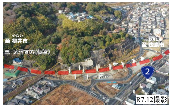
【写真①】大竹市小方地区の施工状況
