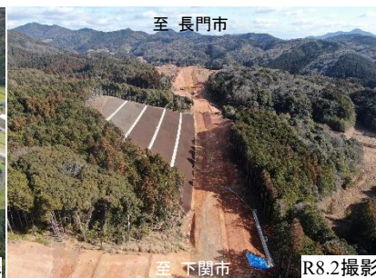
【写真②】稲見地区施工状況
