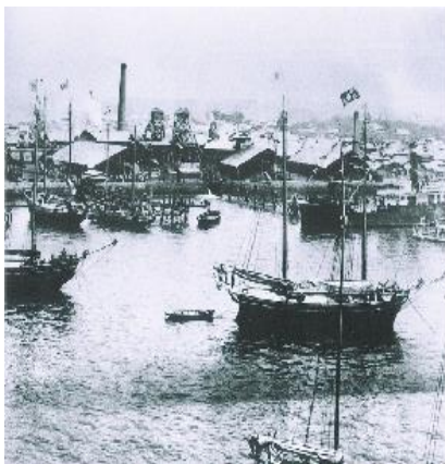
↑石炭積込桟橋と帆船(宇部市・大正15年頃)／明治から大正まで、石炭の輸送は主に帆船でおこなわれていました。
