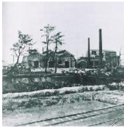
←整備の進む 海軍練炭製造 所／明治37年 に開設され、そ の後石油の需 要が増大したた め、さらに施設 の拡張整備が 行われました。
