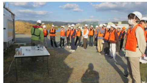
施工会社から説明を受ける様子
