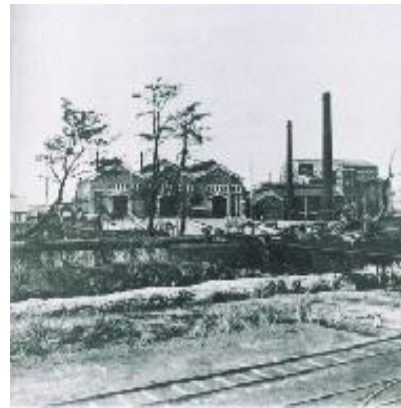
←整備の進む海軍練炭製造所／明治37年に開設され、その後石油の需要が増大したため、さらに施設の拡張整備が行われました。
