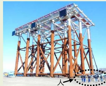
基礎杭に、鋼管で組み立てた立体トラスを被せた栈橋。人が上着を「羽織る」ことを連想させるので「ジャケット」と言われている。
