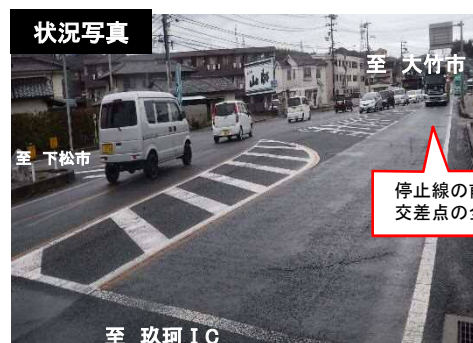
国道2号 錦見交差点 (山口県 岩国市)
