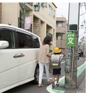
<歩行の支障となる電柱の事例>
