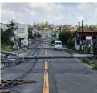
<電柱の倒壊による道路閉塞の事例>
