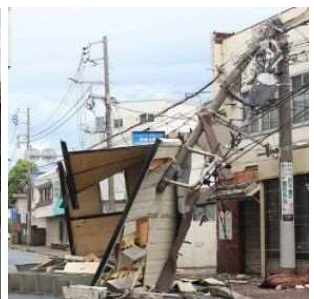
<飛来物による電柱倒壊の事例>
