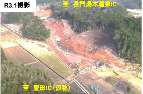
写真① 金道地区施工状況
