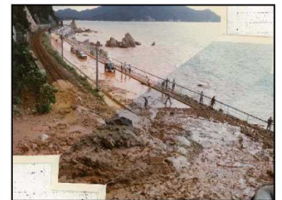
【写真②S55年土砂崩壊の状況】
