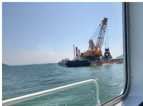
間近で見る浚渫工事の迫力に感動！
