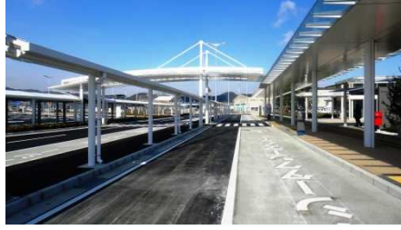
○歩道ルーフ:完成(中国地整)
