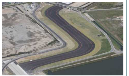
○誘導路:新設舗装完成(中国地整)
