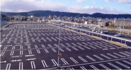
○駐車場:完成(事業者:岩国空港ビル株式会社) 構内道路、連絡通路、場周道路:完成(中国地整)
