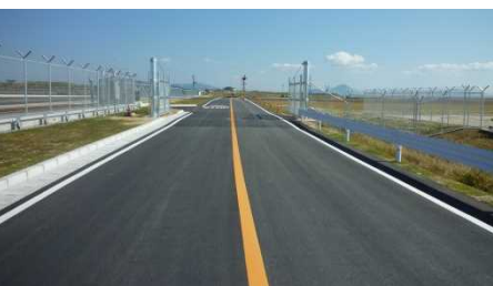
○外周道路:完成(中国地整)
