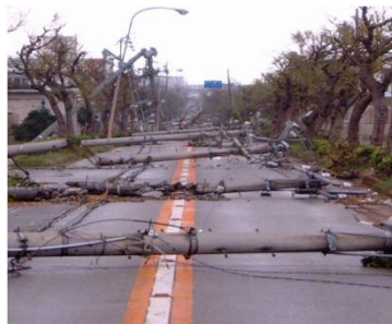
<電柱の倒壊による道路閉塞の事例>
