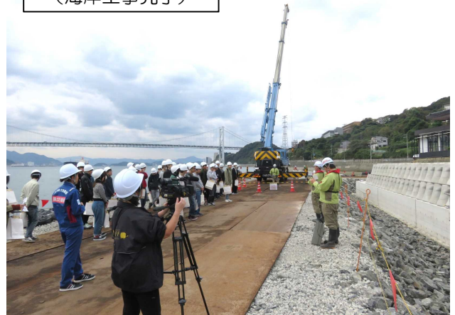
下関港 （海岸工事見学）
