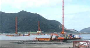
地盤改良工事
