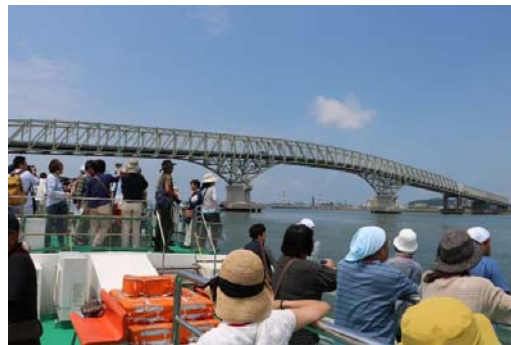
興産大橋を船上より
