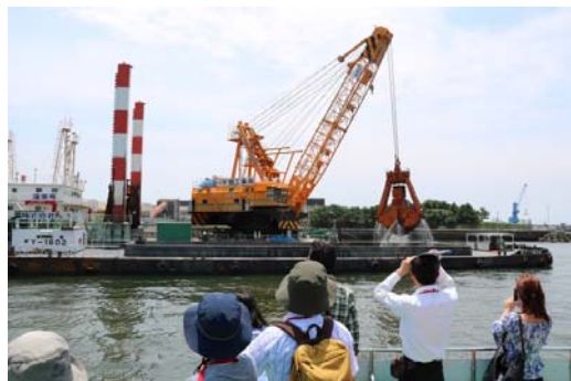
浚渫工事を間近で見学
