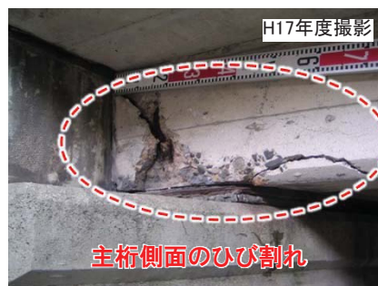
< 架け替え前の旧橋の老朽化の状況 >
