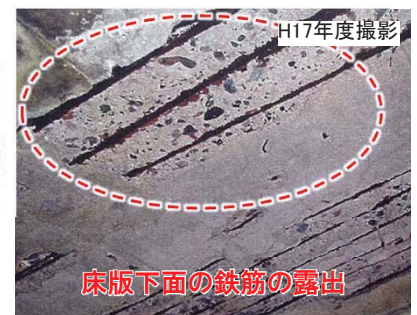
< 架け替え前の旧橋の老朽化の状況 >
