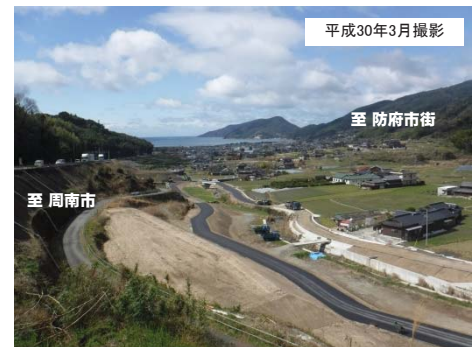
写真① 現在の改良工事進捗状況 (周南市方面から防府市街方面を望む)
