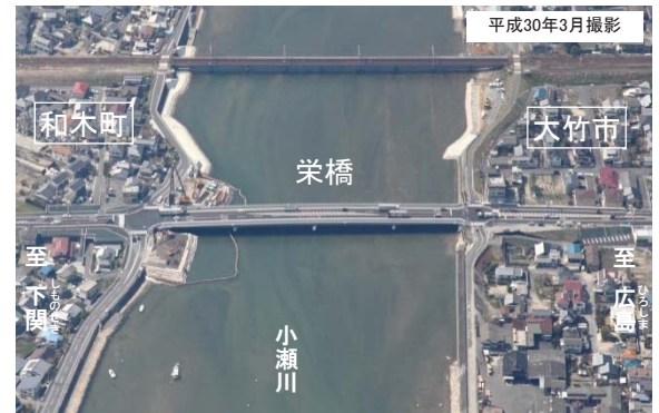
写真① 栄橋の供用状況
