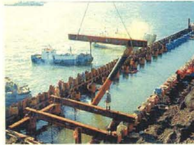
■ストラット部材取付け中
