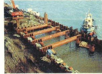
■ストラット部材取付け後
