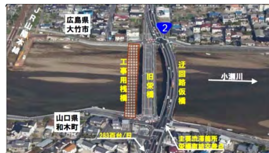
【写真①】施工状況(山口県側から広島県側を望む)
