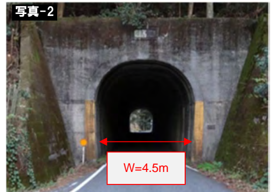
▲狭隘トンネル
