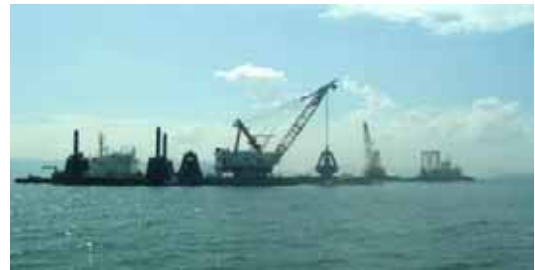
写真-2.2 実証実験区の施工状況(平成19年度)
