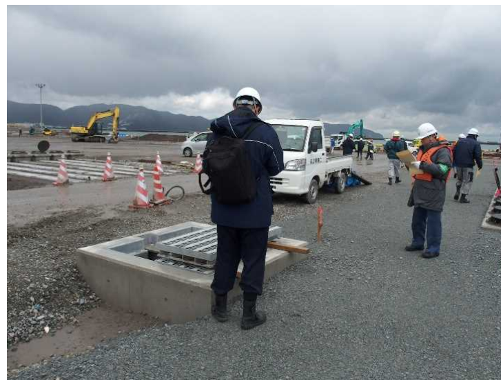
パトロール実施状況 (ターミナル駐車場舗装)
