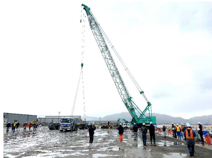
パトロール実施状況 (PC桁架設)
