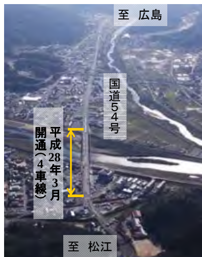
上空より里熊大橋周辺を望む
