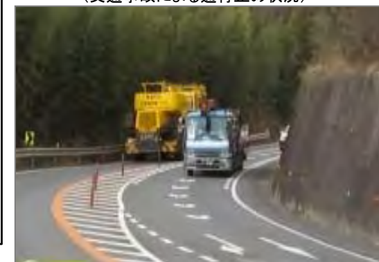
並行する国道9号 (線形不良箇所)
