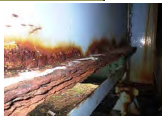
損傷状況(部材の断面欠損)
