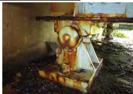
損傷状況(部材の断面欠損)
