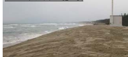
サンドリサイクル施工後
