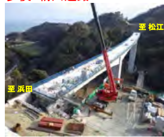
口田儀第1高架橋
