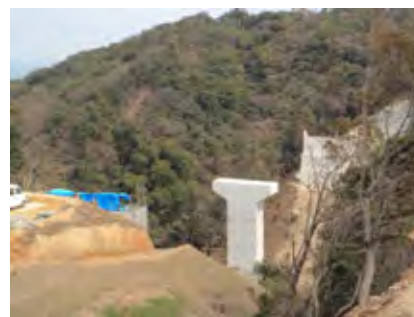
夏井川橋 整備状況
