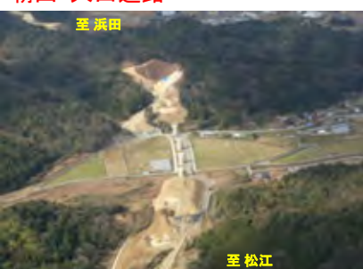
波根川橋付近から西を望む
