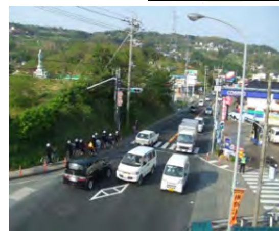
浜田市熱田町 ※事故対策予定箇所
