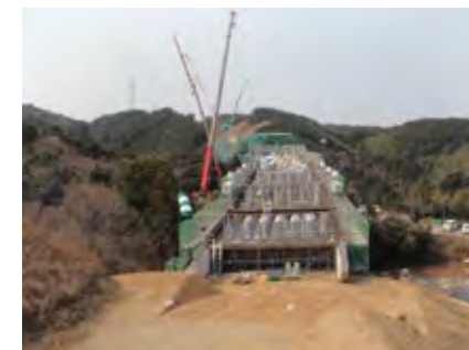
西村高架橋 整備状況
