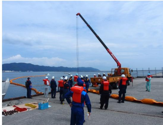
オイルフェンス回収のためにユニックを使用し岸壁上に引き上げています。
