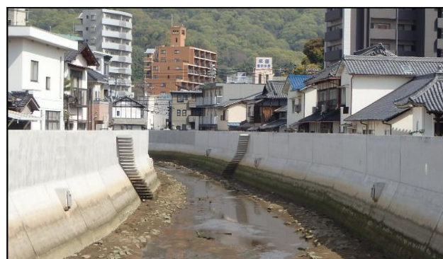
整備後の状況(宮下川)
