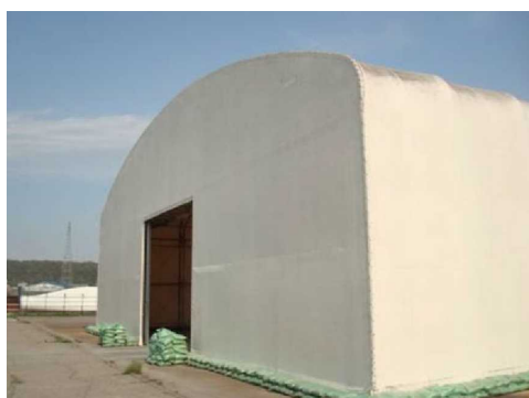
図 酒田港に設置されたテント仮設倉庫
