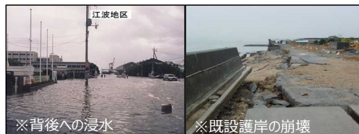
図 H16年台風18号による浸水被害(広島県海浜)
