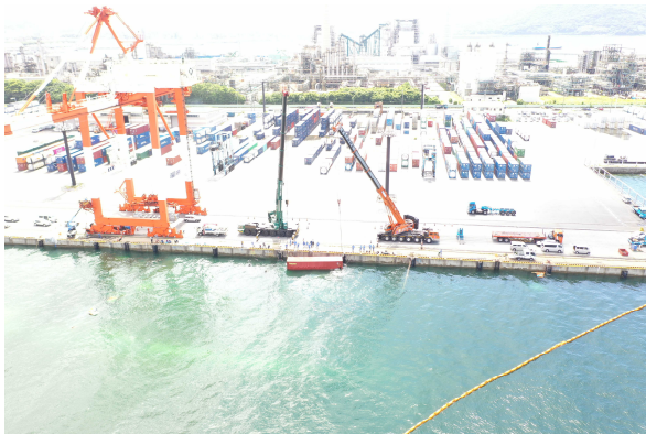
<コンテナを引き上げる様子>
