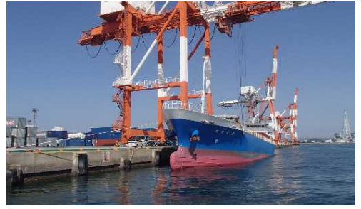
整備後(耐震強化岸壁)
