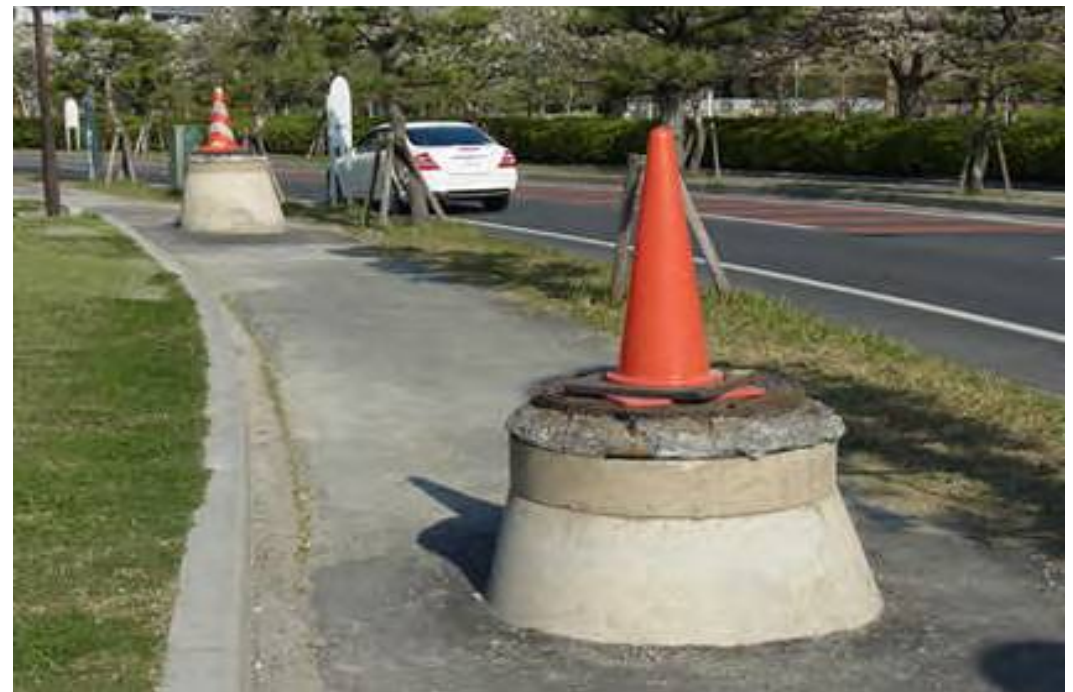
マンホールの浮き上がり(浦安市)
