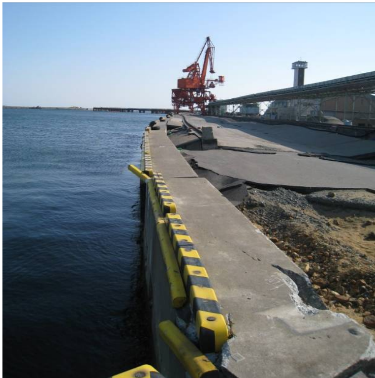
側方流動による岸壁の損壊(小名浜港)
