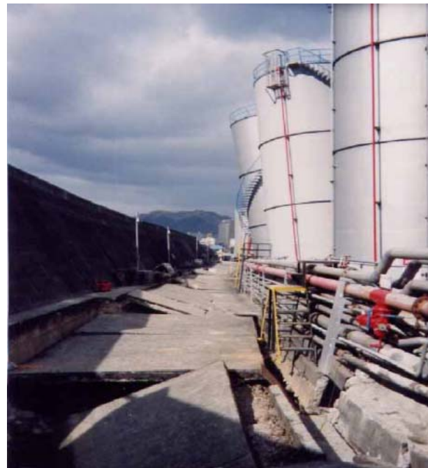
側方流動による 危険物貯蔵の傾斜・移動
