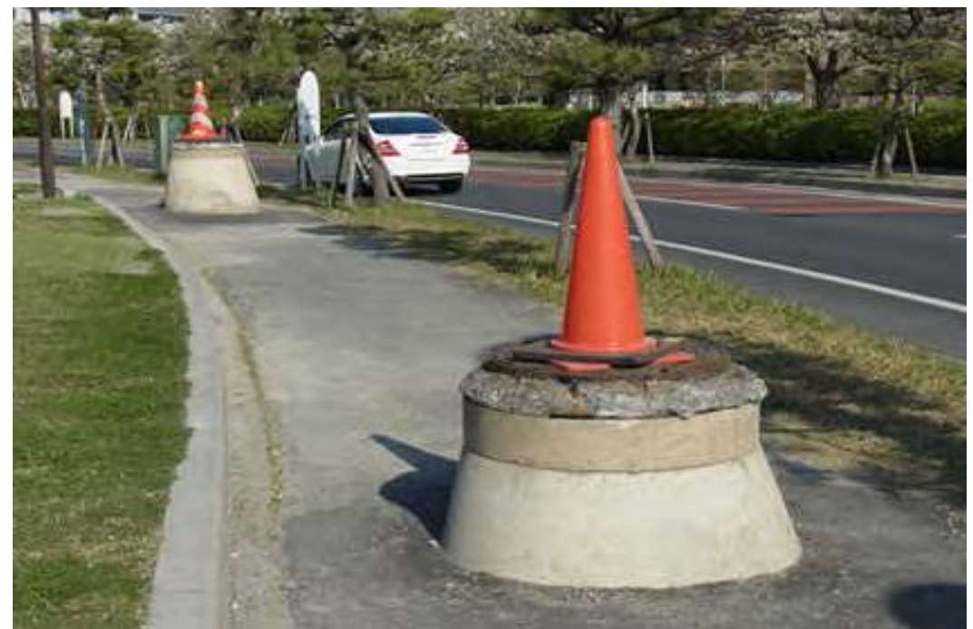
マンホールの浮き上がり(浦安市)
