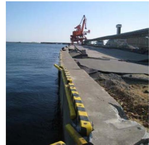
(被害状況1) 石炭用アンローダ設置岸壁(-10m)背後で1mを超える段差
