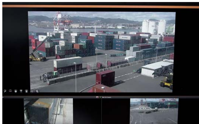
○コントロールセンターのモニター
