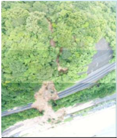
E31 広島呉道路 (天応西IC~坂南IC) 【道路崩落】
