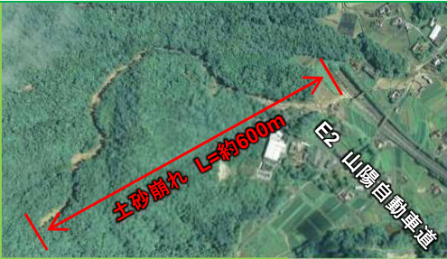
②約600mの土砂崩落を受けた山陽道 (東広島市志和トンネル東口)
