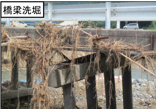
おかやま やがけちょう こやんたに こやんたに 岡山県矢掛町 町道古屋谷線（古屋谷橋）
