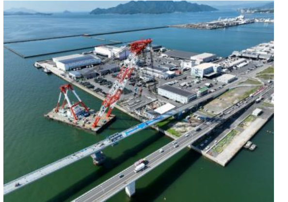
臨港道路廿日市草津線 整備中
