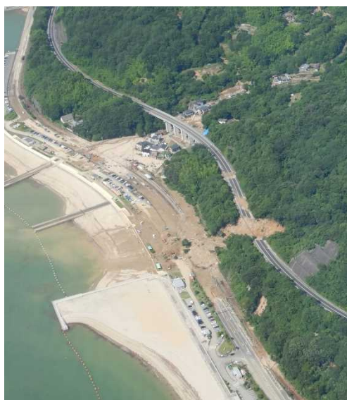
H30豪雨災害時の JR、幹線道路の遮断（坂町）
