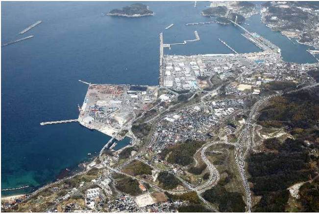
浜田港臨港道路 2018.3開通
