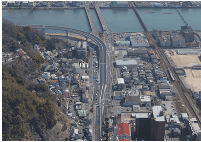
東広島・呉自動車道 阿賀IC立体化 2022.3
