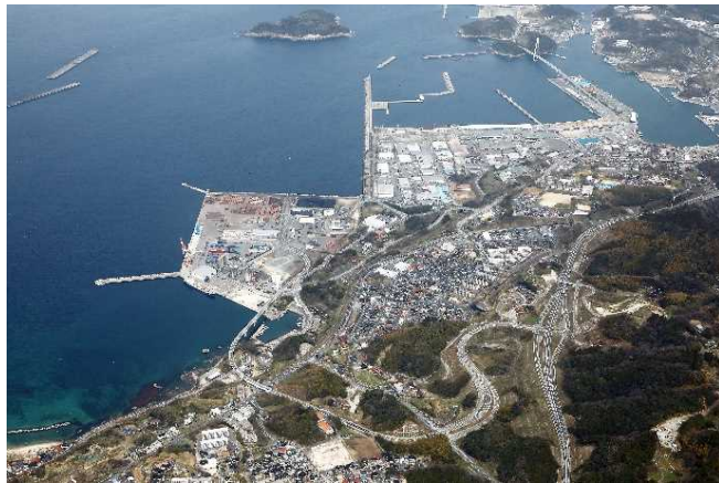
浜田港臨港道路 2018.3開通
