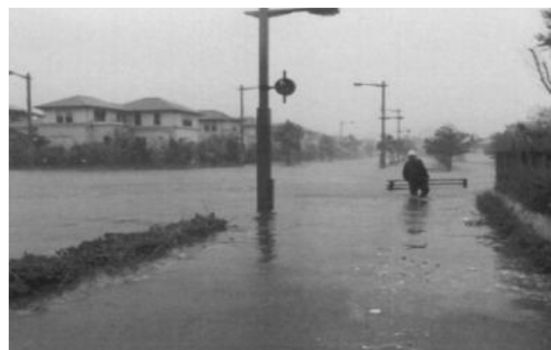
浸水被害の状況 (尼崎西宮芦屋港海岸)
