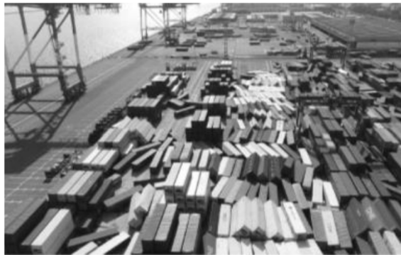
コンテナの散乱状況(神戸港)
