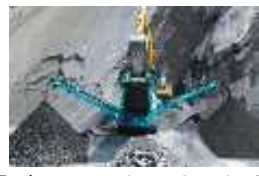
【ガレキを除去する機械】
