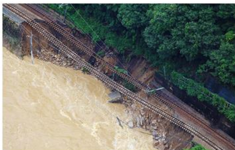
本郷～河内駅間 冠水
