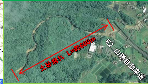
②約600mの土砂崩落を受けた山陽道 (東広島市志和トンネル東口)
