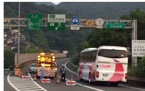
都市間バスの通行: 広島呉道路の呉IC
