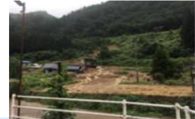
E2A 中国道 (新見IC~北房IC)【法面崩落】
