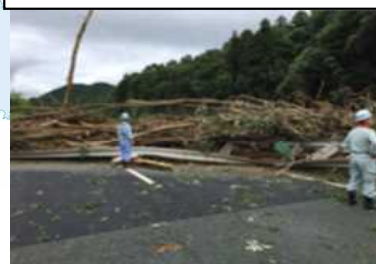
E2山陽道 (高屋JCT) 【土砂流入】
