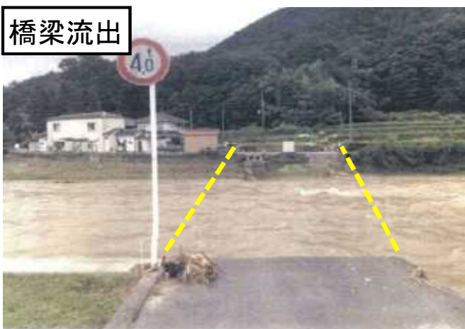
ひろしま ひろしま あんだ 広島県広島市 広島市道（安駄橋）
