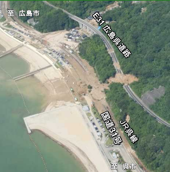
①沿岸に集中する交通手段への土砂崩壊 (坂町水尻)
