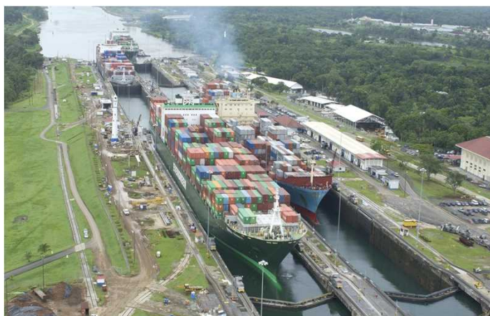
ガトン閘門(現況)
