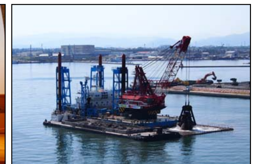
泊地(水深12m)浚渫工事の実施状況
