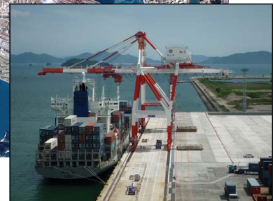
供用開始した岸壁・荷役機械での コンテナ船の荷役状況 (写真提供：岡山県)
