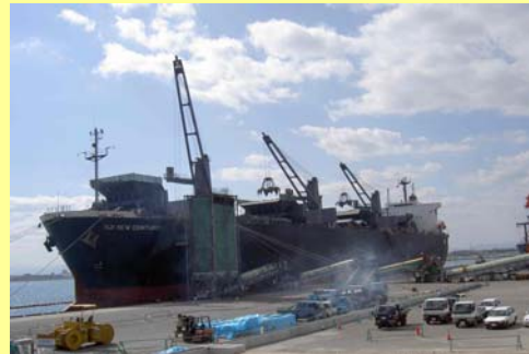
境港 木材チップ取扱い状況
