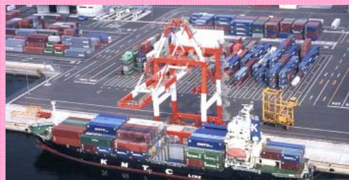
福山港 コンテナ貨物取扱い状況
