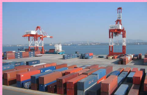
水島港 コンテナ貨物取扱い状況
