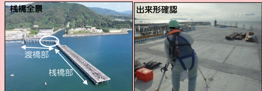
徳山下松港下松地区栈橋（～19m）工事事例
