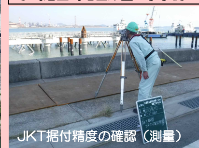
水島港玉島地区岸壁工事事例
