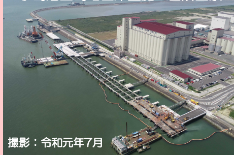
水島港玉島地区岸壁施工箇所全景
