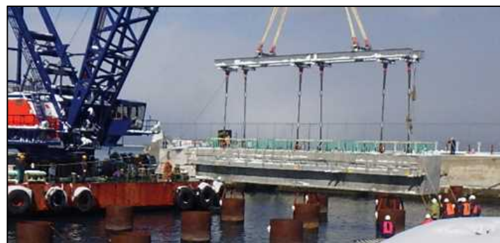
プレキャスト部材を用いた栈橋上部工の施工 (潮待ち等によらず昼間作業が可能)
