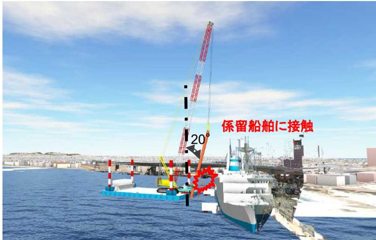
杭打設時における鋼管杭の振れ確認
