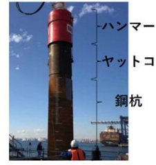
ヤットコを介した鋼杭打設
